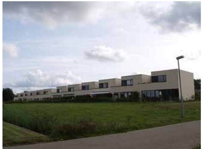
Ekisterende bebyggelse i to etager med tagterrasser i den østlige del af lokalplanens område
