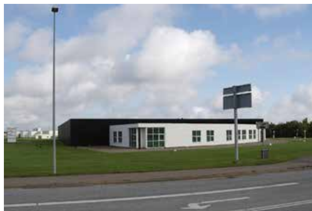
Den eksisterende bygning på Vejlevej 1
