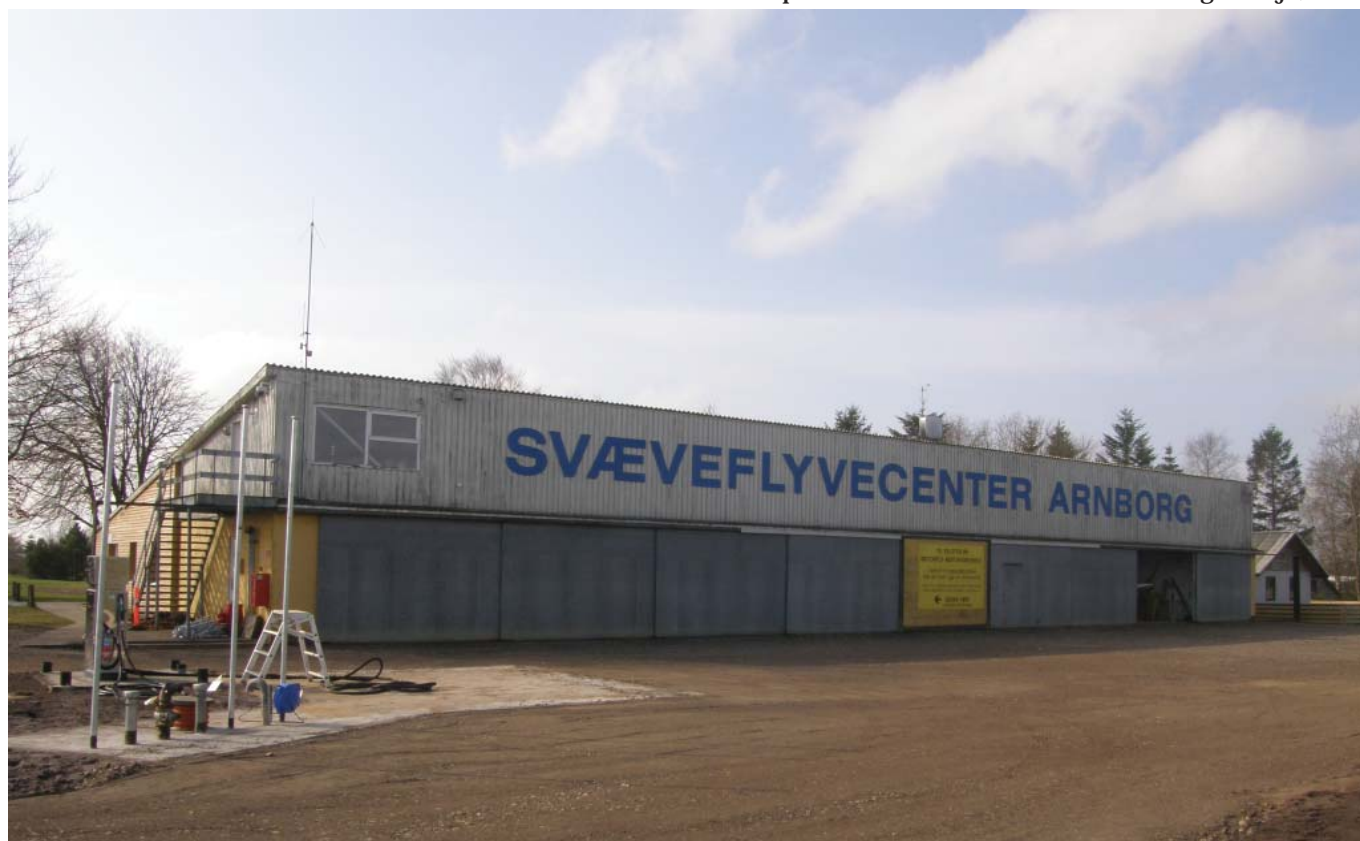
Svævecentrets hovedbygning med bl.a. administration og kursuslokaler
